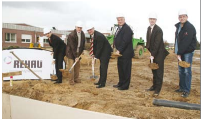
Gemeinsam mit Werkleiter Hans-Martin Bachmann und weiteren Unternehmensvertretern setzten Landrat Albert Focke und Visbeks Bürgermeister Heiner Thölke den ersten Spatenstich.
